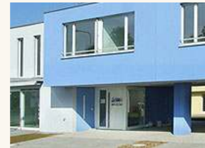
Eingangszone mit Carport
